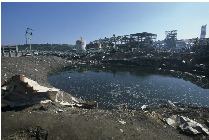
AZF site after the explosion. Photo courtesy: Grande Paroisse ( http://www.azf.fr ).
